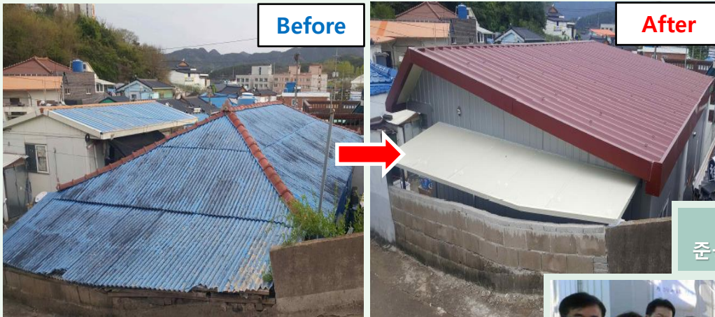
기존 낮은 청정고로 천정고 증설 및 지붕틀 구조 신설
