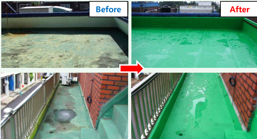
노화된 방수재 제거 및 복합화(시트) 방수 조치
