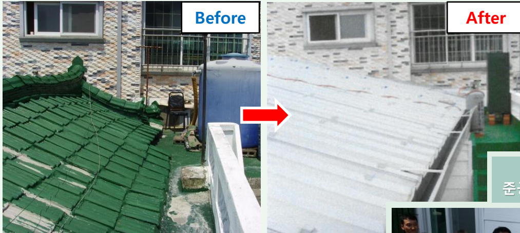
지붕 누수로 인한 지붕개량 공사
