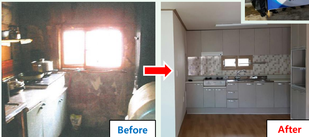
협소하고 열악한 주방을 실내에 위치 수정 주방가구등 설치
