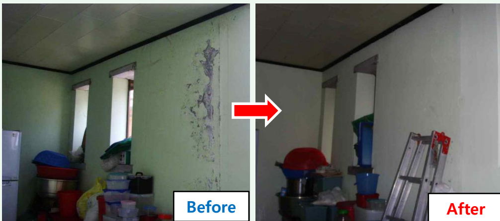
내부 누수로 인해 누수보수 후 재도장 조치
