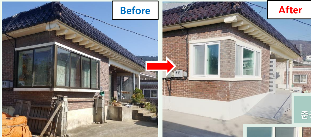
노후화된 기존 건축물의 외관 공사 및 창호 . 벽체단열 사양 개선
