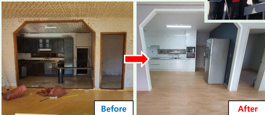
내부 바닥 . 벽지 공사 및 입식 주방가구 설치
