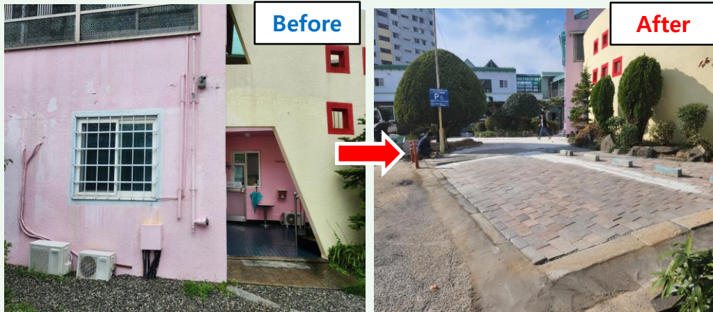
기존 진입로 다갈라 블렌딩 블록 포장 및 주변정리로 안전 환경 개선
