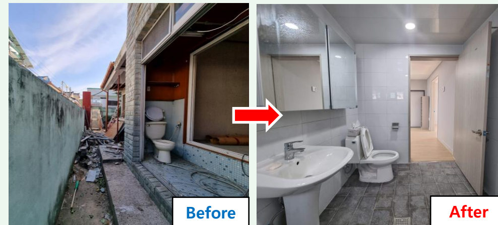
좁고 열악한 화장실을 이용에 편리하도록 변경 및 설치
