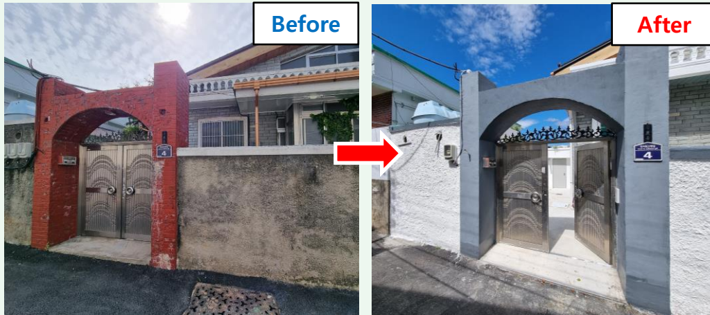
기존의 오래된 현관을 도장작업을 통하여 외관 개선
