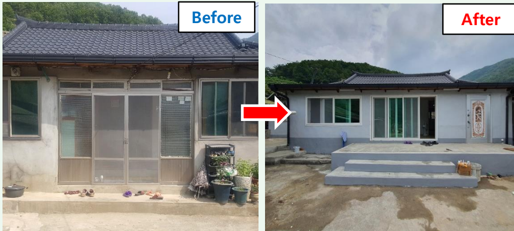
주출입구 외부 테라스 계단 설치 및 창호 개수
